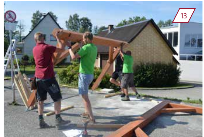
Rückwand aufstellen. Die Stützfüße auf den Betonfundamenten platzieren.
