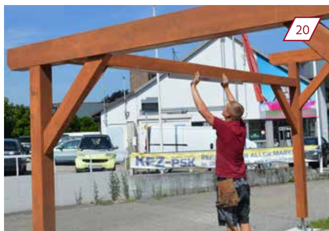
Mit Wasserwaage die Querlatten und Säulen ausrichten.
