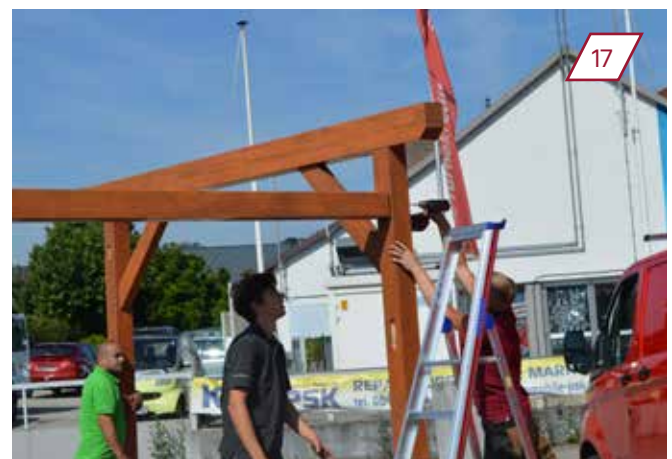
Pfosten mit Säulen verschrauben. Eventuell noch nicht komplett festschrauben, um vorab noch die Kopfbänder leichter anbringen zu können.
