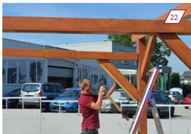
Gegebenenfalls mit Schlaghammer und Latte anpassen.
