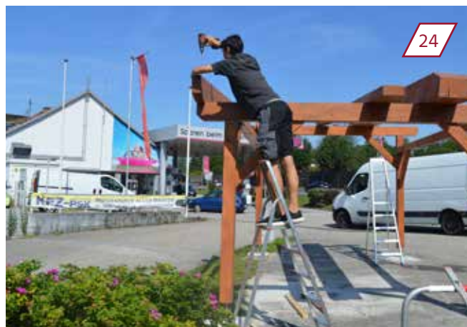
Sparren beiden Enden am Pfosten anschrauben.
