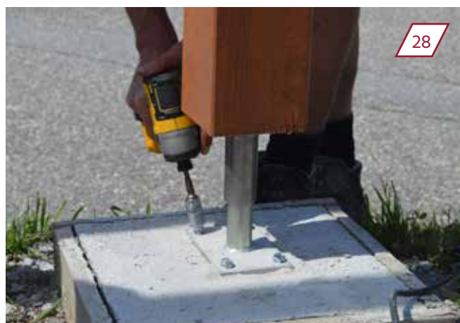
Betonschrauben mit Schlagschrauber oder Gabelschlüssel festschrauben.
