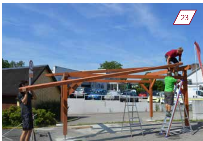
Die Dachsparren auf das Grundgerüst legen.
