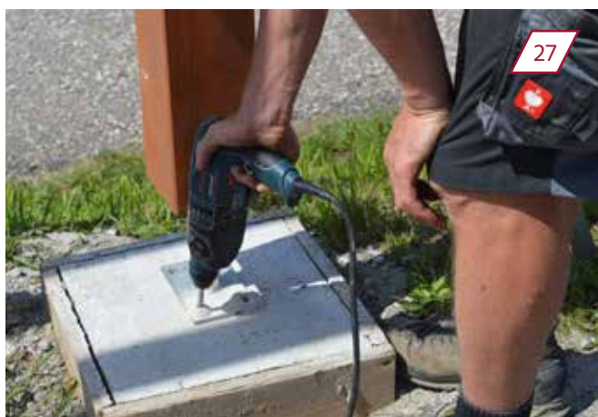
Stützfuß mit Betonfundament verschrauben.
